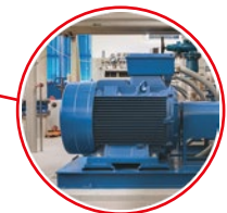
poła silników nN
