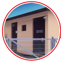
stacje kontenerowe i rozdzielnie wewnętrzne
