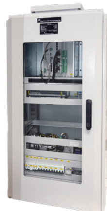
Szafa obiektowa PV
