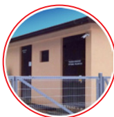
stacje kontenerowe i rozdzielnie wewnętrzne
