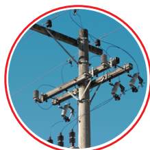
ячейка отходящей линии
