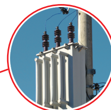
ячейка трансформатора
