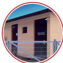
контейнерные станции и внутренние распределительные устройства
