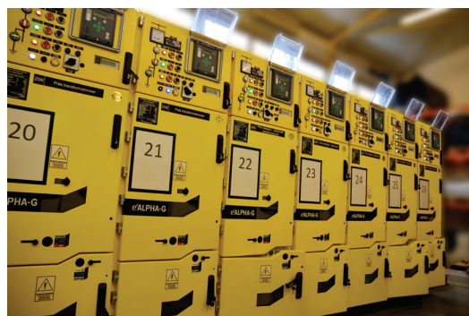
Fot. 2. Rozdzielnica górnicza e 2 ALPHA dla KGHM SA (zainstalowana 1200m pod ziemią)
